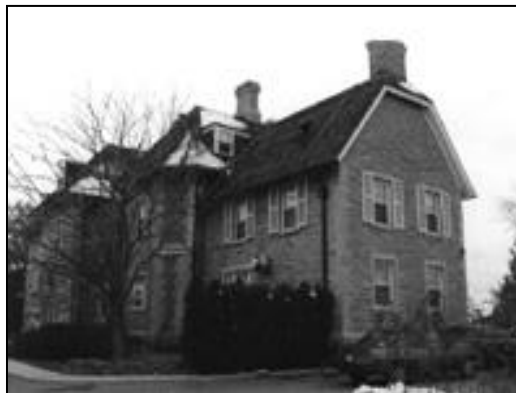
Les matériaux et les formes extérieures du bâtiment sont des éléments historiques importants.
