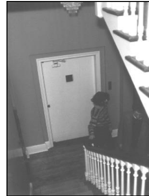
La porte de l'ascenseur ouvre dans l'escalier.
