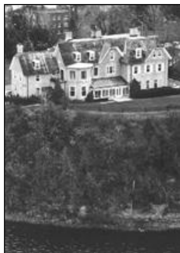
L'escarpement est sujet à l'érosion.
