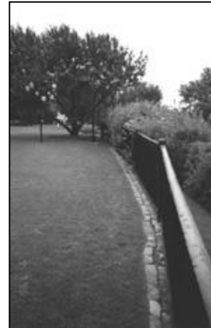
On doit reconstruire la clôture en haut de l'escarpement.
