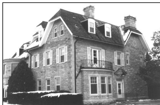
Les fenêtres d'un édifice sont un élément majeur de son caractère. Les parties détériorées devraient être restaurées.
