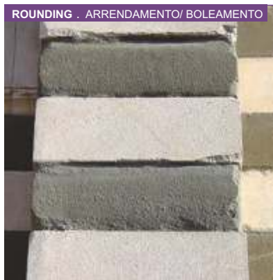
EROSION . EROSÃO
